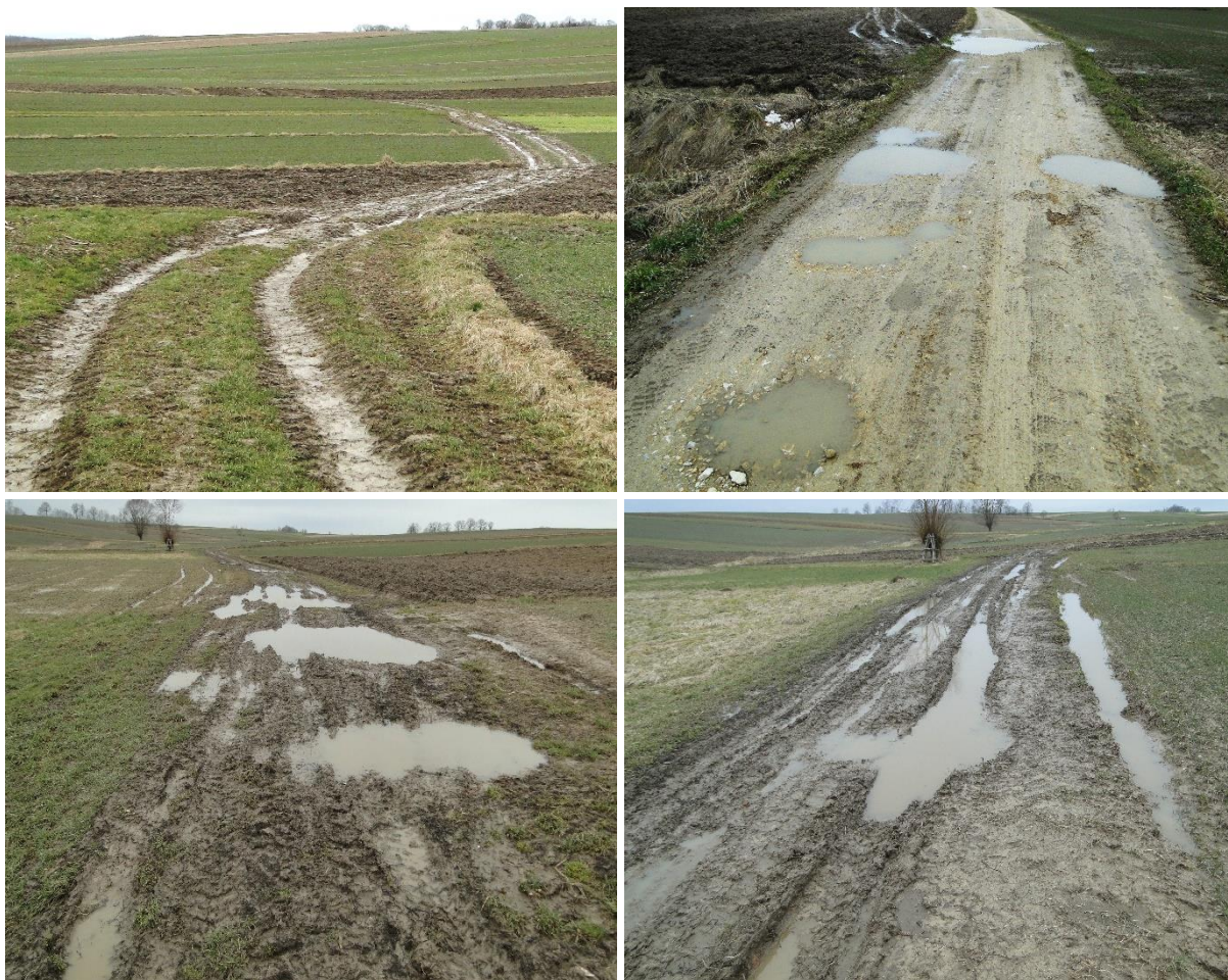
Rysunek 20. Przykłady złego stanu dróg dojazdowych do gruntów rolnych na obiekcie badań Źródło: opracowanie własne.
