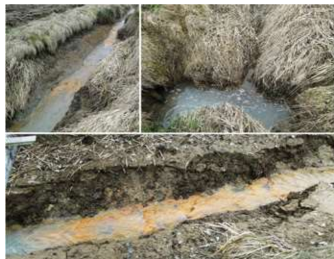
Rysunek 10. Po lewej i u dołu ciek melioracyjny z wyraźnymi śladami wykwitów żelazisto-próchnicznych, po prawej u góry miejsce ujścia zanieczyszczonej wody z kilku zbieraczy do rowu melioracyjnego (fot. J.M. Pijanowski)
