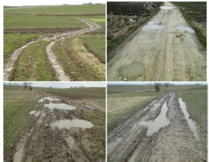
Rysunek 12. Przykłady złego stanu dróg dojazdowych do gruntów rolnych na obiekcie badań (fot. J.M. Pijanowski)
